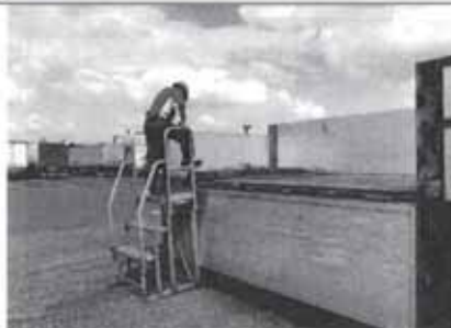
墜落・転落防止：昇降台の導入
